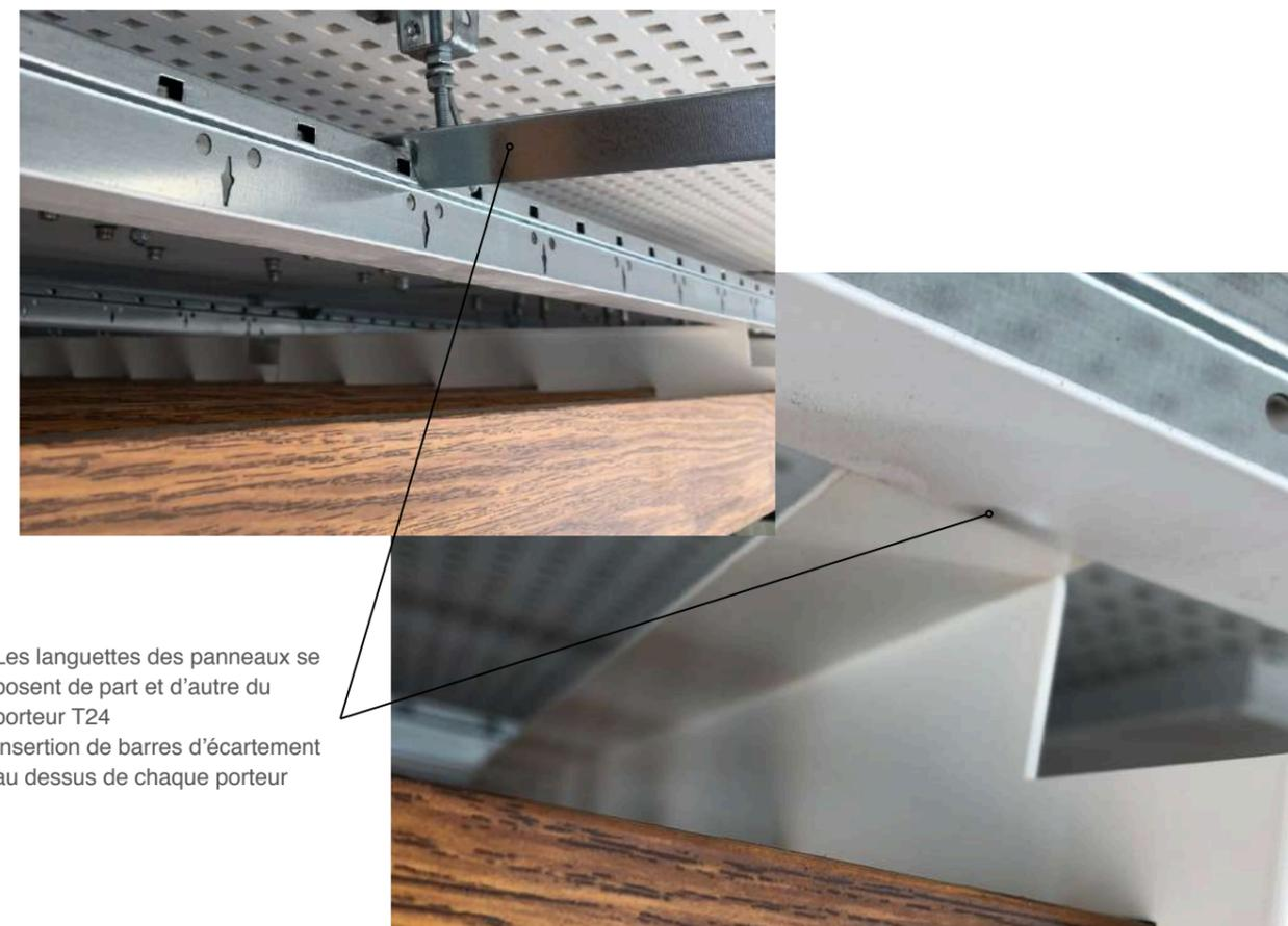
Les languettes des panneaux se posent de part et d'autre du porteur T24
